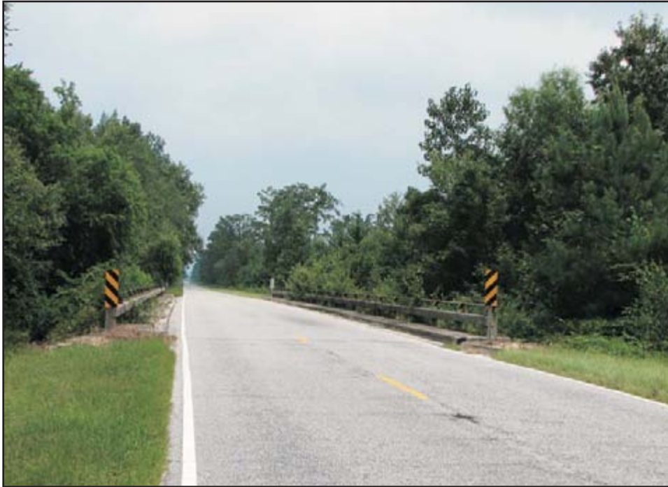
29A. Bridge (Site U/67/0676)
